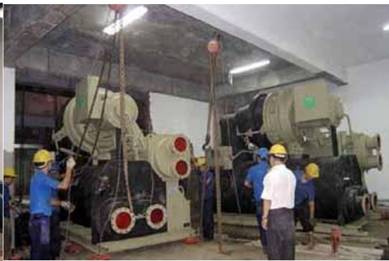
中央空调主机安装
