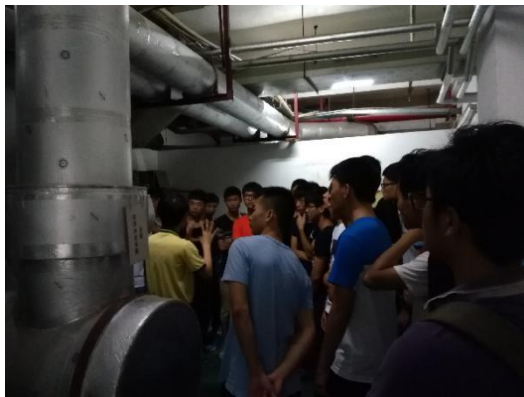
大型冷库制冷系统
