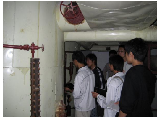
大型冷库制冷系统
