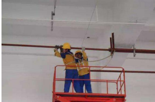
中央空调水管安装
