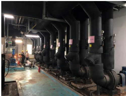
中央空调水泵安装
