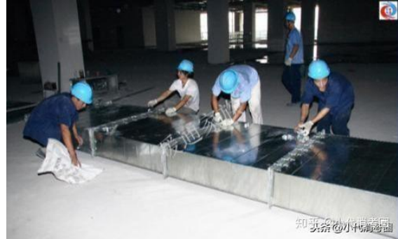
中央空调风管安装
