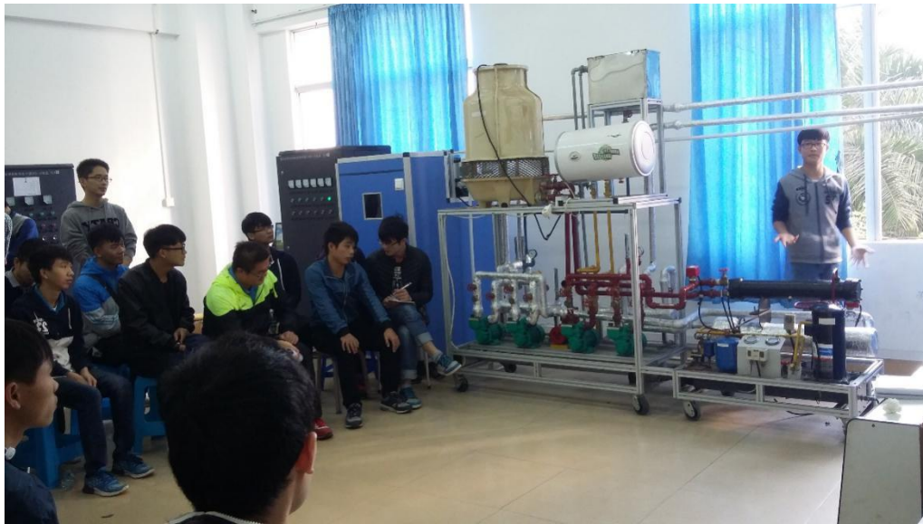
学生在讲解中央空调系统的工作原理
