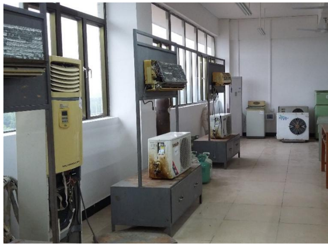
小型制冷装置实训室
