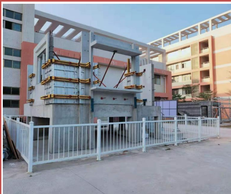
装配式建筑安装施工实训室
