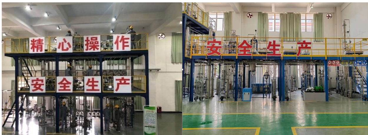
图一：化工仿真工厂常减压仿真实训装置以及聚丙烯反应实训装置
