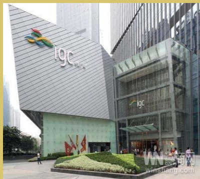
IGC 天汇广场
