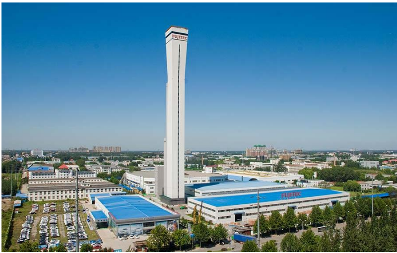
富士达总部翔云塔： 河北省地标建筑/地上高度 151 米/ 30 层/13 个井道/最高速度 8 米/秒
