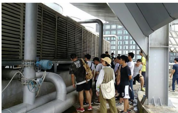
参观大型水冷中央空调系统
