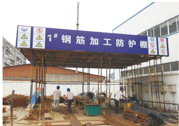
钢筋加工现场实习
